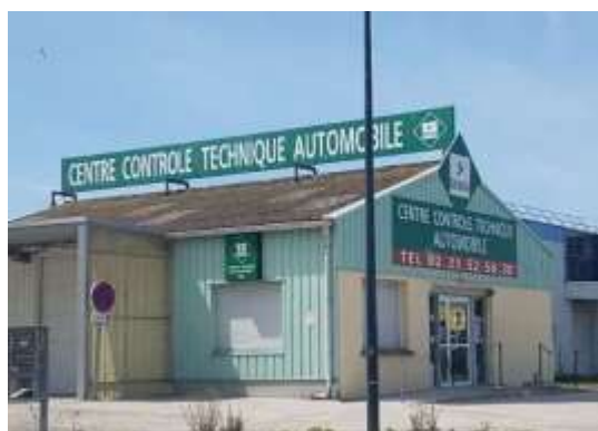
En toiture Secteur Croix Desilles-La Houssaye
