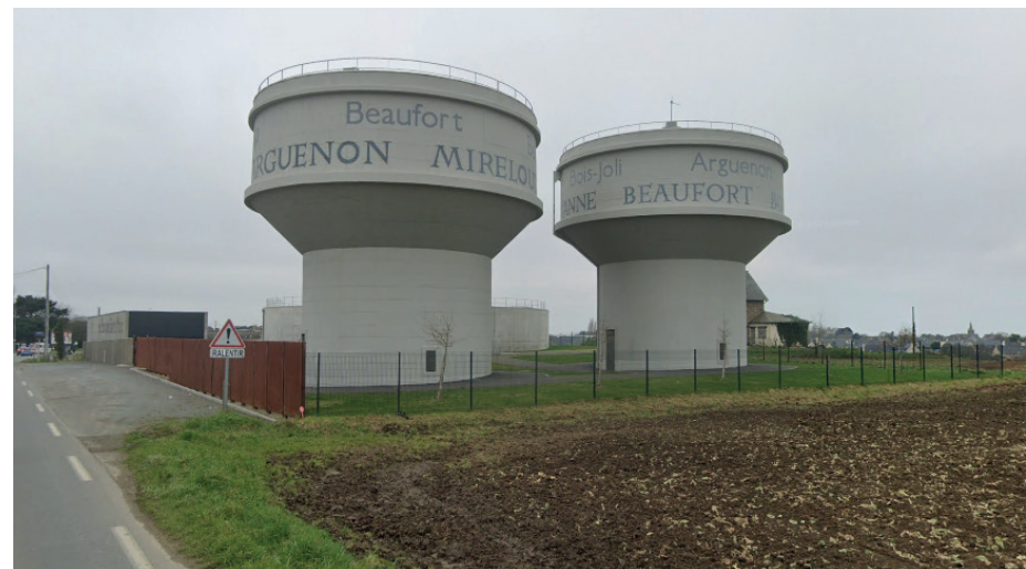
Figure 139 : Prise de vue du Château d'eau de Saint-Malo - février 2023 - Google
