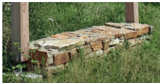
Figure 254 : Exemple de muret de pierres sèches
