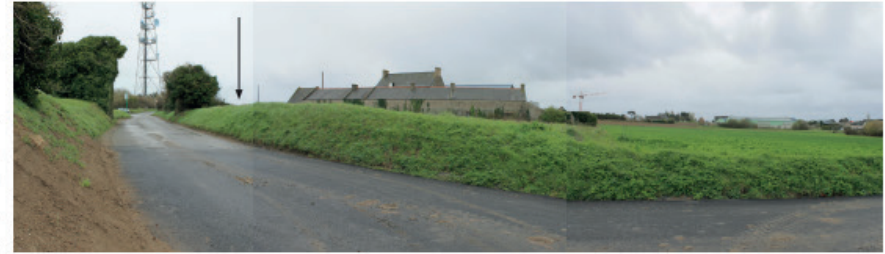
1 Le talus Nord
