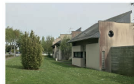
Maison de fonction du personnel de l'IUT
