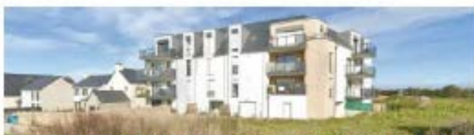
Logements collectifs - Bonne rencontre Sud - 4 Niveaux
